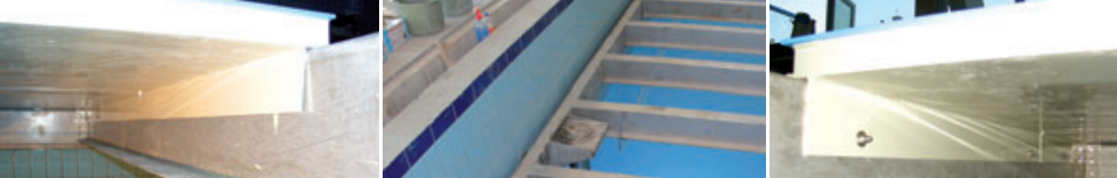
Abb. v.l.n.r.: mit Befestigungsplatten verschweißter Schwimmbeckenboden, Stahlgerüst zur Hydraulik, verschraubter Schwimmbeckenboden.
